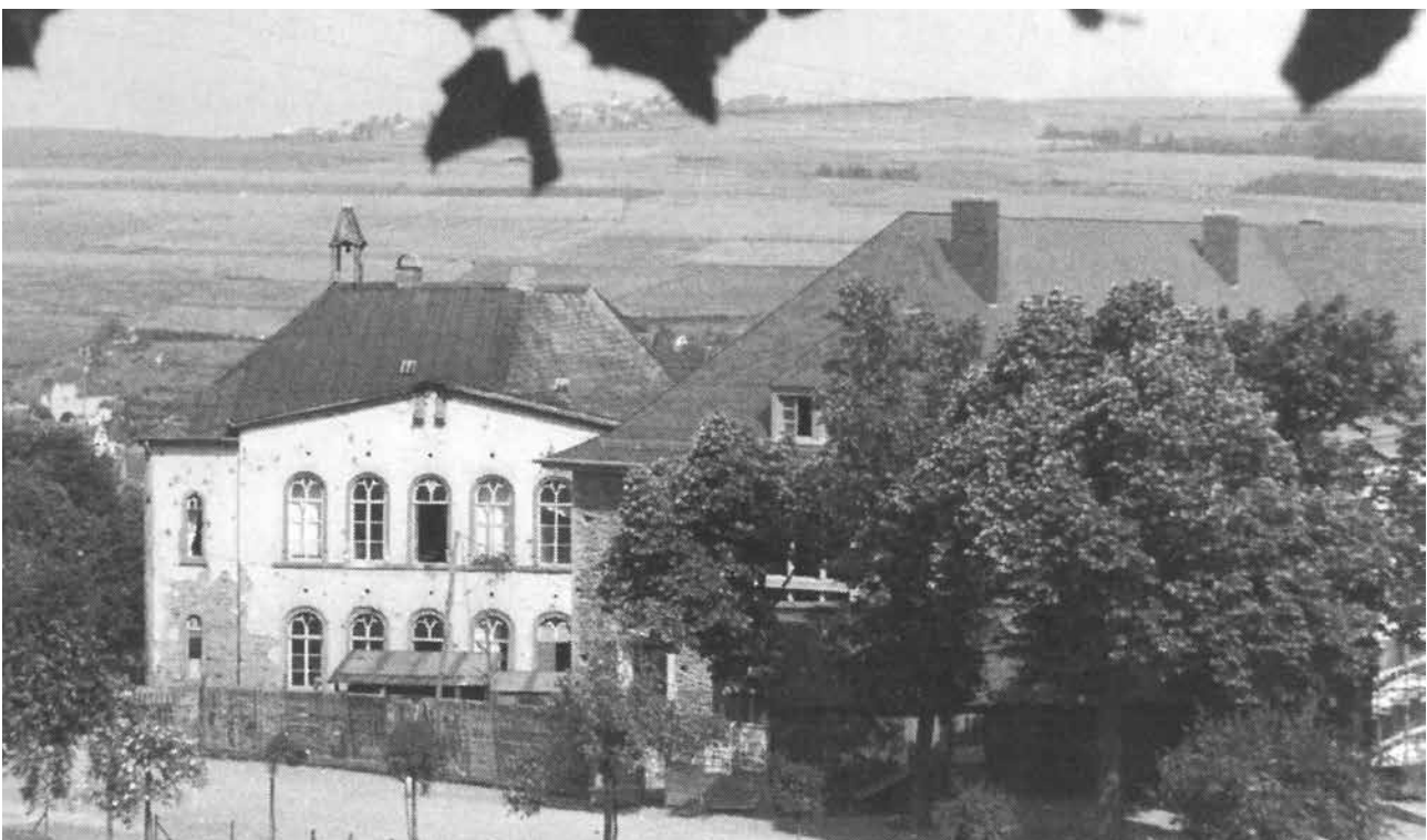
Die Wiltzer Mädchenschule wurde in der Ardennenoffensive stark beschädigt
