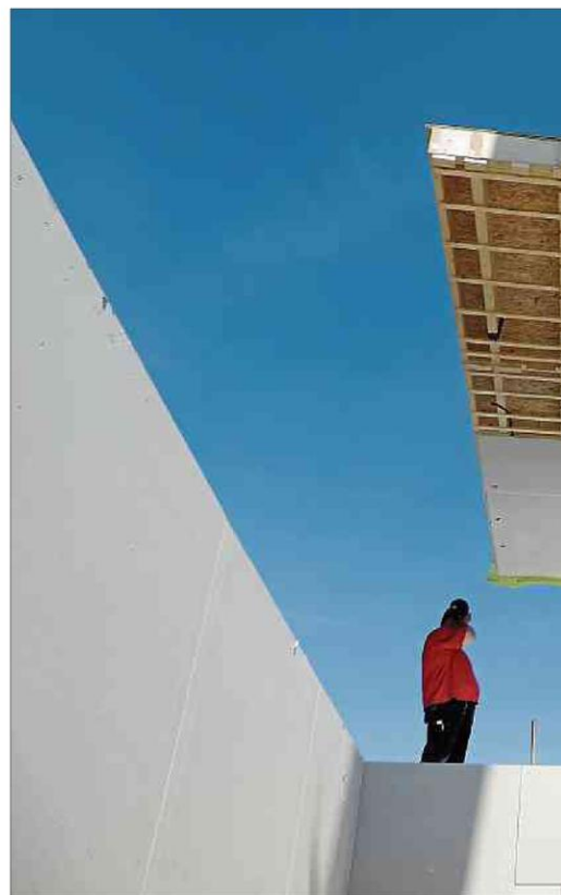
Bei dem Pilotprojekt in Wiltz testete Heliosmart seine selbstentwickelte „zirkuläre“ Bauweise. Foto: Heliosmart
