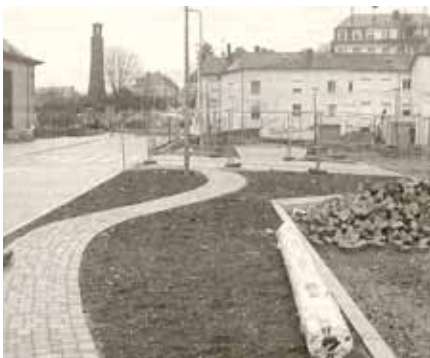
Die Arbeiten im Schulberg schreiten zügig voran
