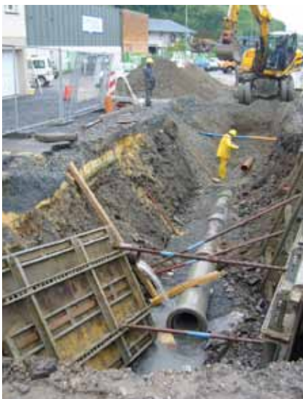
Die „Avenue de la Gare“ im Umbau
