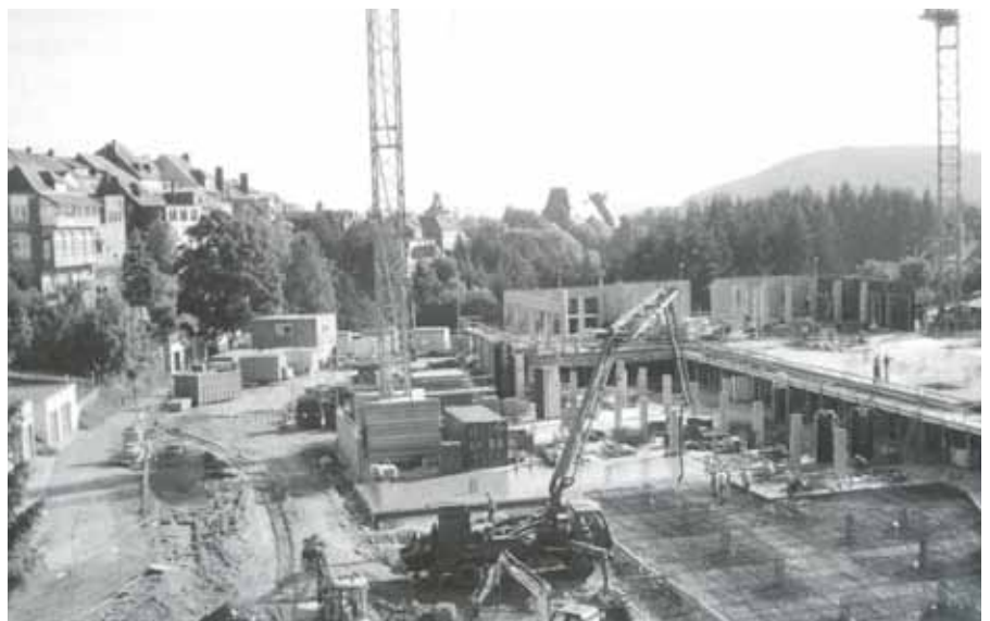
Die Arbeiten am neuen Altenheim haben begonnen
