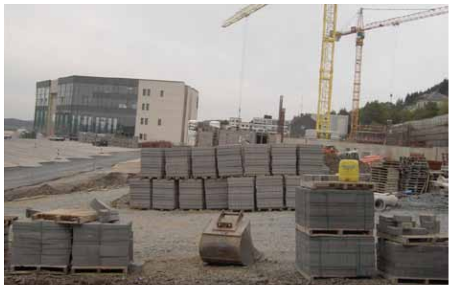
Baustelle „Lycée du Nord“ im September 2006
