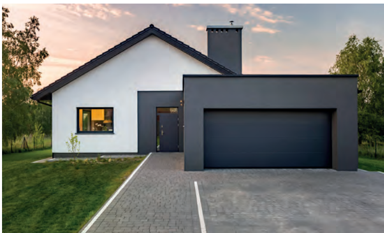
Exemple d'accès habitation en pavés béton.
