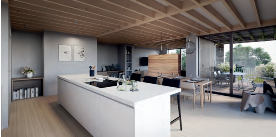
Construction en ossature bois légère - finitions murs en chaux, murs en pisé vers le salon et gîtage apparent au plafond.
