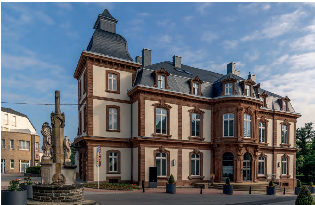
Hôtel de Ville de Wiltz, rénové entre 2017 et 2021 en intégrant les principes de l'économie circulaire.
