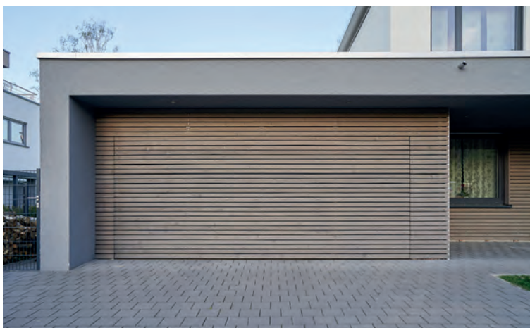
Beispiel einer Fassade mit Holzverkleidung und Kalkputz.
