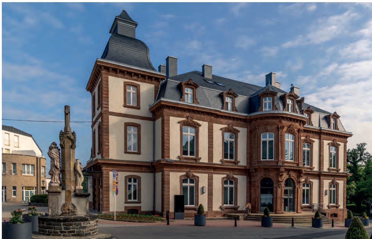
Wiltzer Rathaus, Renovierung des Gebäudes zwischen 2017 und 2021 unter Berücksichtigung der Prinzipien der Kreislaufwirtschaft.
