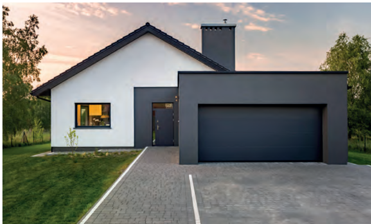
Beispiel eines Hauszugangs mit Betonpflastersteinen.
