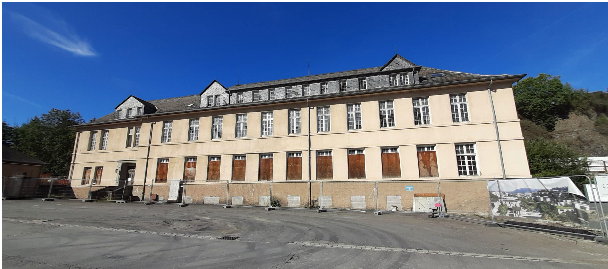
Réhabilitation du bâtiment administratif Ideal à Wiltz
