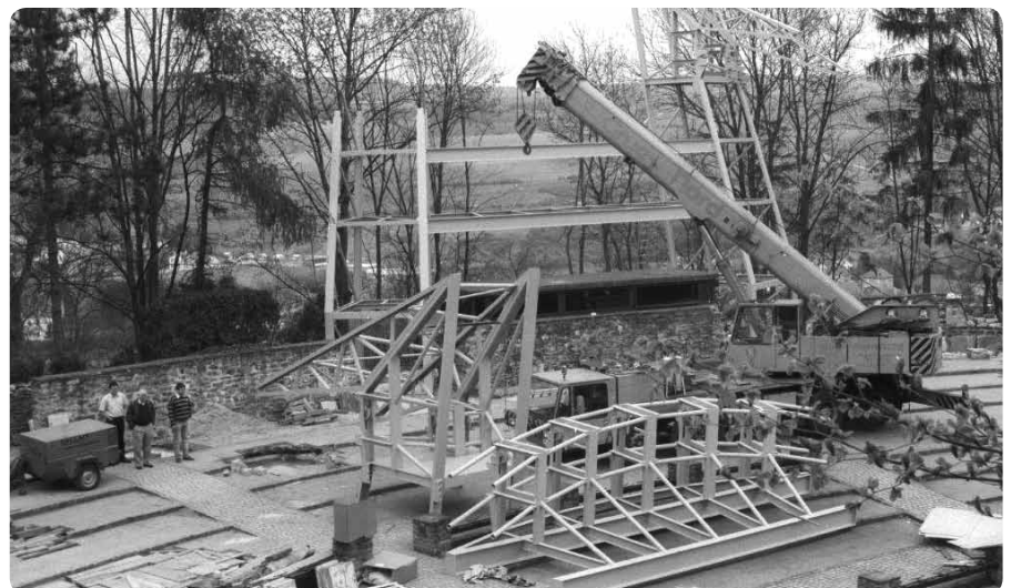
Das Metallgerüst des ersten Festivaldaches wird aufgerichtet
