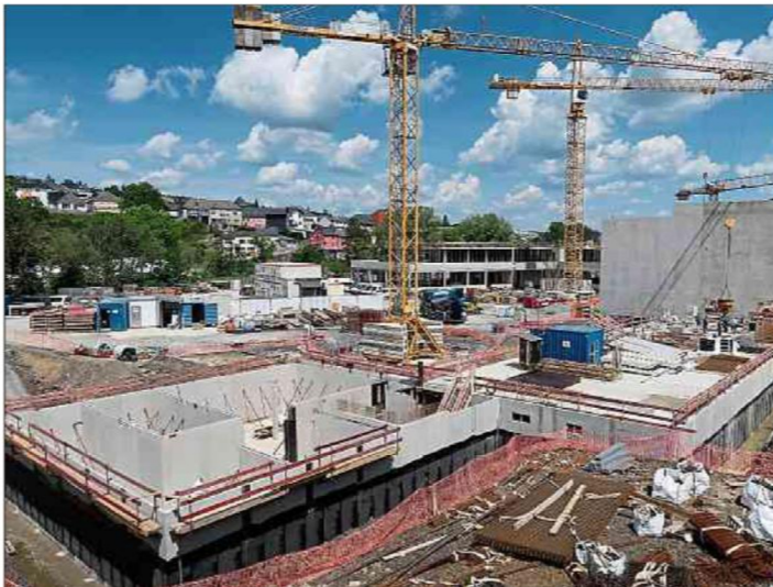
Der sich im Rohbau befindende Schul- und Sportcampus „Géitz“ ist das erste sichtbare Element von drei großen Urbanisierungsprojekten, die die Stadt Wiltz stark verändern werden.
